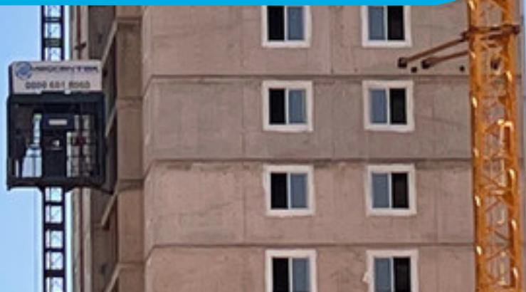
O Elevador de Cremalheira é um equipamento robusto, de avançada tecnologia. Tractionado por motores elétricos, possui dispositivo de freio eletromagnético que oferece elevado grau de segurança.
