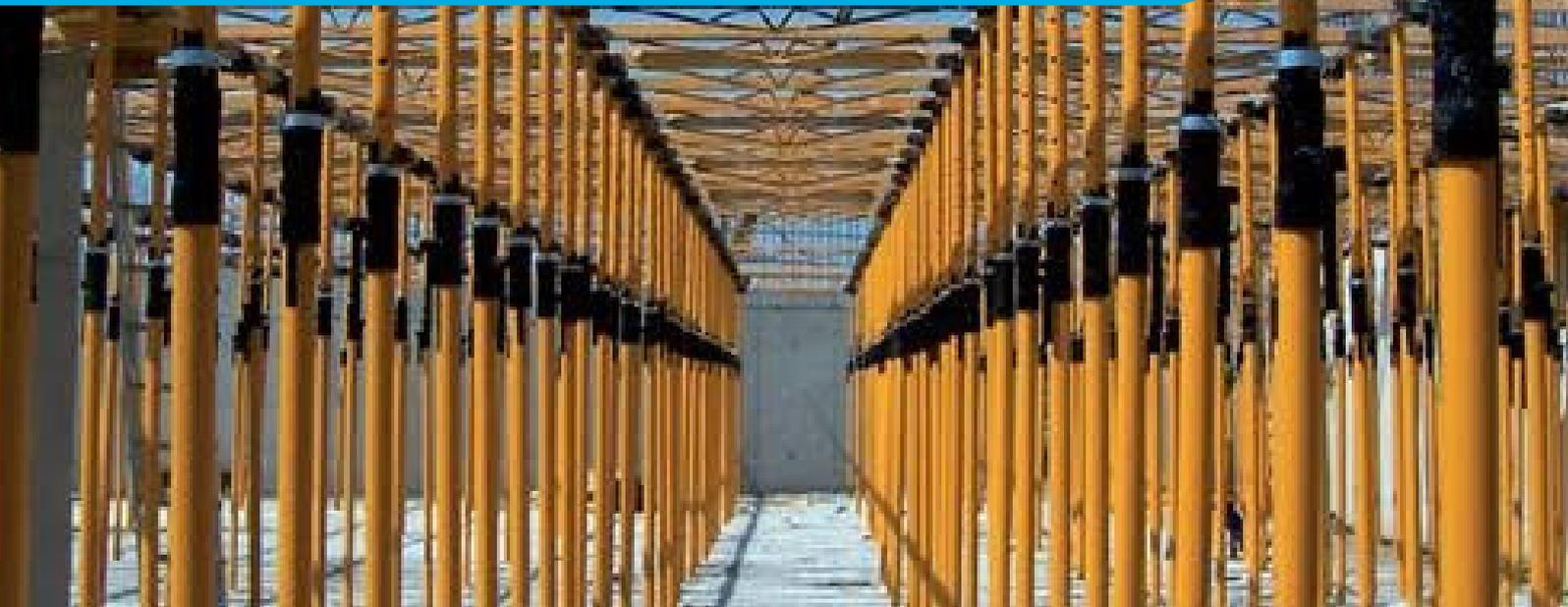
**As Escoras Metálicas são fáceis e práticas de serem montadas e fornecem apoio provisório à elementos estruturais, lajes, vigas, permitindo nivelamento da estrutura de concreto. Prática, segura e rápida. Ajustáveis de 2,00m a 4,80m.**
