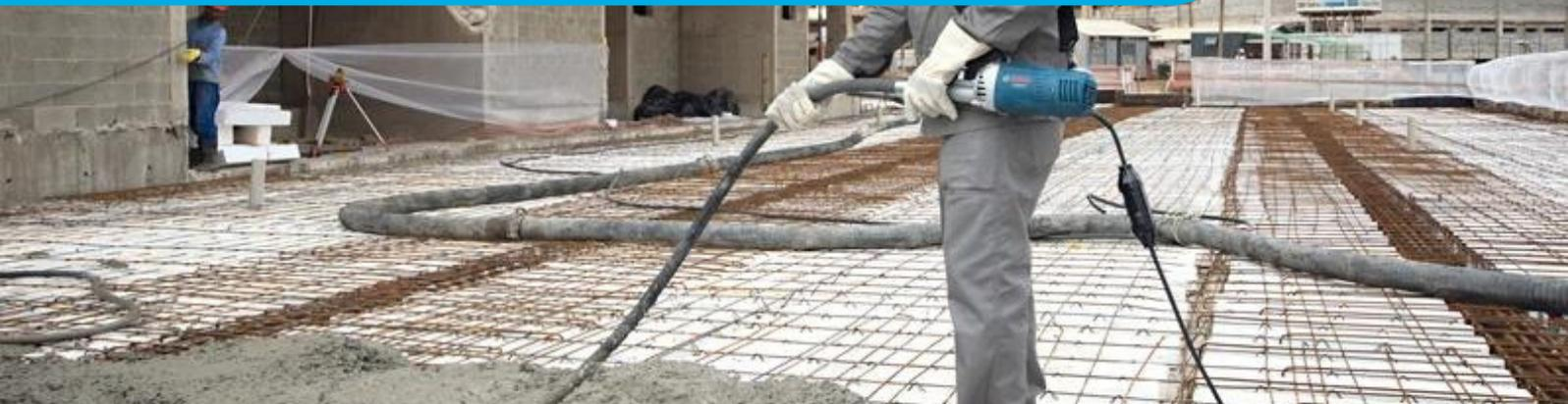
**Os vibradores de imersão são indicados para transmitir vibrações no concreto ainda fresco, eliminando os espaços vazios nas peças, servindo para também assentar o concreto.**
